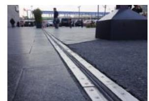
Juntas de dilatação totalmente estanques de embutir
