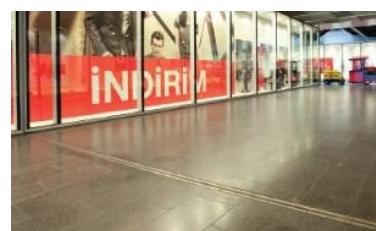
Juntas de dilatação totalmente estanques de embutir
