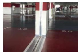
As juntas de pavimentos montados na superfície são resistentes ao tráfego de veículos leves. Pode ser aplicado em revestimentos de pavimentos acabados, como pavimentos de betão bruto. Montado no chão com âncoras de aço.
