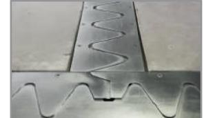
Especialmente projetado para resistir a cargas de empilhadeiras e usado em estruturas industriais com características de design linearmente curvado e corpo de aço.
