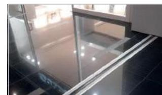
As Juntas de dilatação de acabamento são usadas para folgas de 50 mm. Geralmente, é adequado para pedestres e carga de veículos leves.
