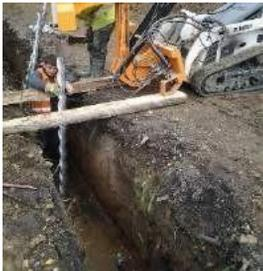
Las micro-estacas helicoidales STATI-Pile son fácilmente tratadas en obra y la prueba puede realizarse inmediatamente, después a su aplicación.
