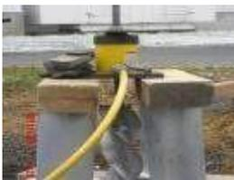
Las micro-estacas helicoidales STATI-Pile también son aplicables cuando hay esfuerzos a la tracción. Esta función es fundamental, para estabilizar paredes de contención, en estabilización de arribas, y donde se pueden esperar esfuerzos de tracción (tiendas, toldos, grúas, torres de telecomunicaciones y electricidad, etc.). Lo mismo se aplica a la construcción de las fundaciones de nuevos edificios en lugares inadecuados o condiciones dinámicas atípicas.
