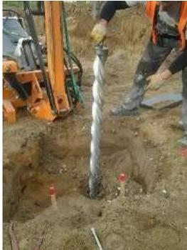
Las micro estacas STATI-Pile se suministran en segmentos, con uno de los extremos con un varón de acero inoxidable roscado y en el otro extremo una rosca para apriete y garantizando la unión perfecta, duradera y ajustable entre los segmentos. En dos diámetros de 60 y 100 mm, en aleación de aluminio 0,3 AISi7Mg
