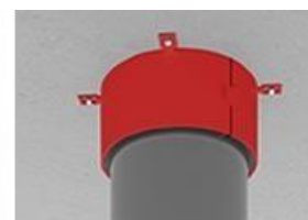
4. Preencha as lacunas com mástique acrílico intumescente
