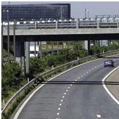
Em conexão com a extensão do sistema de auto-estradas em Copenhague, Dinamarca, as pontes em torno do Motor 3 foram construídas com aço inoxidável ARMINOX®.
