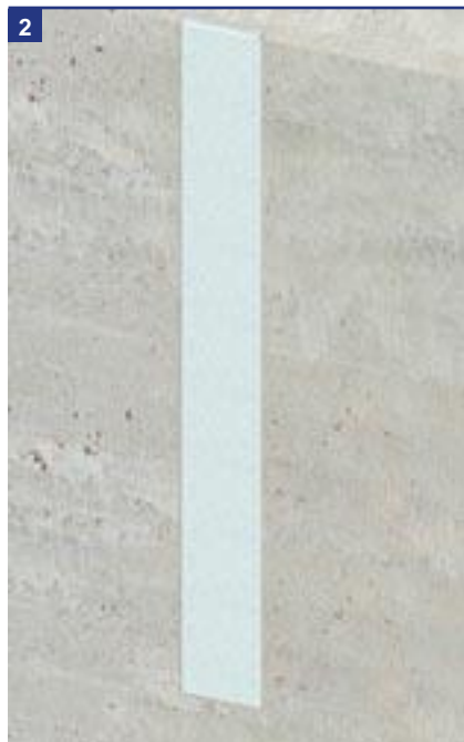
2 Bata na cofragem para revelar a tampa de aço.
