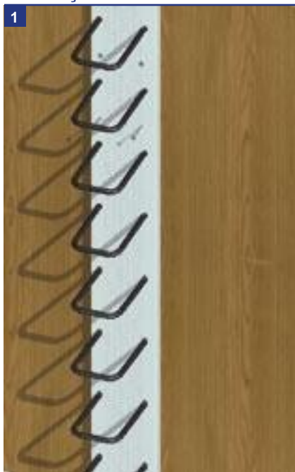
1 Pregue o Eazistrip à cofragem e deite o betão.
