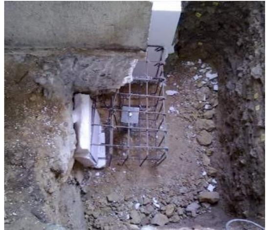
O sistema de micro estacas helicoidais STATI-Pile foi inicialmente desenvolvido para reparos leves de edifícios com fundações estaticamente deterioradas, mas hoje sabemos que a sua aplicação é muito versátil e eficaz. Em combinação com os sistemas de varão helicoidal, podemos conceber soluções integradas e adequadas ás condições particulares de cada projeto e situação.
