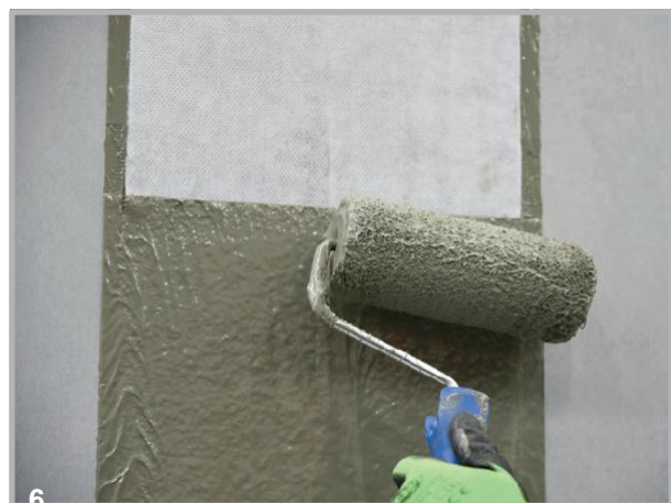
6 Aplique a segunda camada de revestimento. Espessura da camada: aproximadamente 1,2 mm Utilização: aproximadamente 0,6 kg por metro/junta A área de borda do não tecido deve ser completamente coberta.
