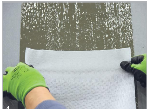
4 Alinhe e pressione suavemente o não tecido.
