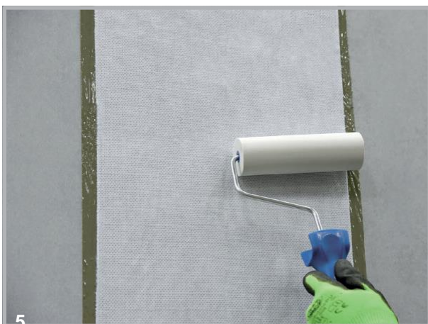
5 Enrole completamente o não tecido no revestimento com o rolo de pressão. Este passo de trabalho permite aplicar a segunda camada após aproximadamente 2-3 horas, dependendo da temperatura e humidade do ar.
