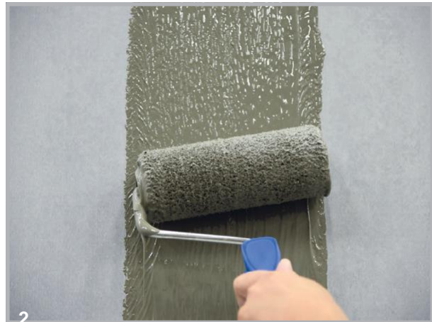
2 Aplique a primeira camada de revestimento. Espessura da camada: aprox. 1,2 mm Uso: aprox. 0.6 kg por metro/junta
