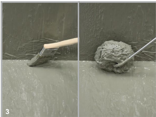
3 Há um rolo de pincel e canto para o filete e outras áreas.
