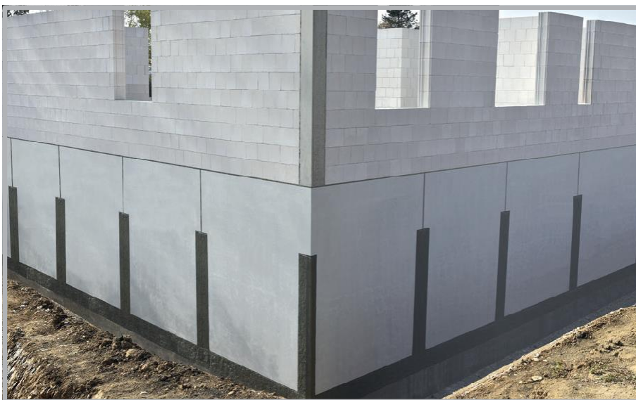
Juntas horizontais e verticais seladas
