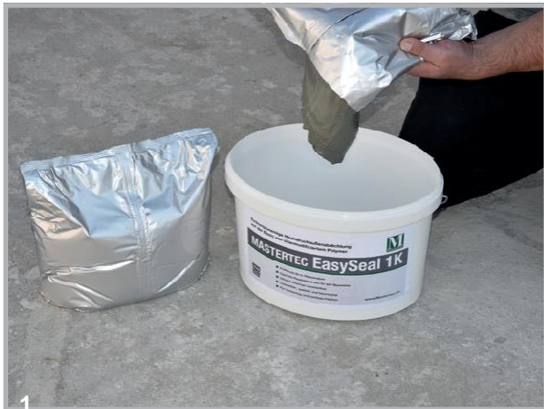
1 Abra os sacos e deite o revestimento no balde.
