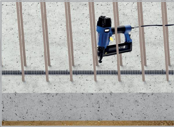
Instalação com perfil de rede de fixação e pregos
