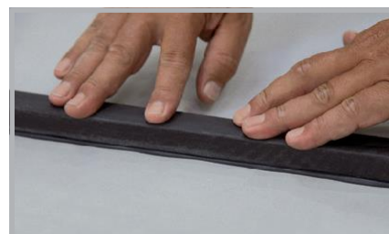
Pressione a fita inchada na cama adesiva
