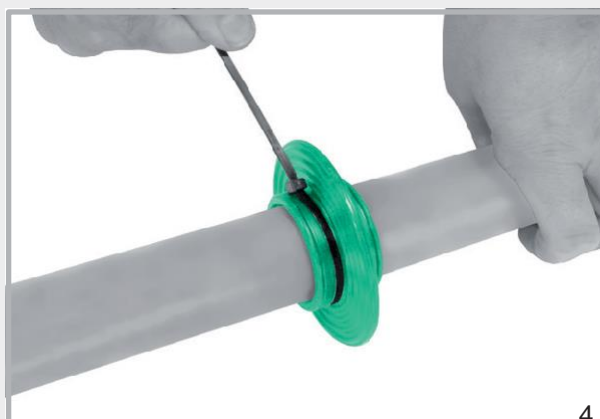
Aperte as duas correias de fixação à mão
