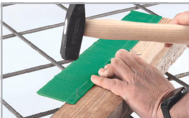
Fixe o pente de forma para a madeira quadrada
