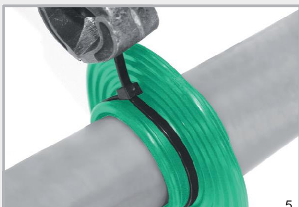
As correias de fixação também podem ser apertadas usando alicates
