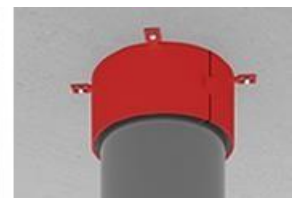
4. Preencha as lacunas com mástique acrílico intumescente
