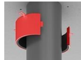
1. Instalar COLAR COR FR no tubo
