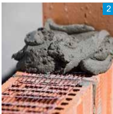
2 Aplicar a camada de argamassa.
