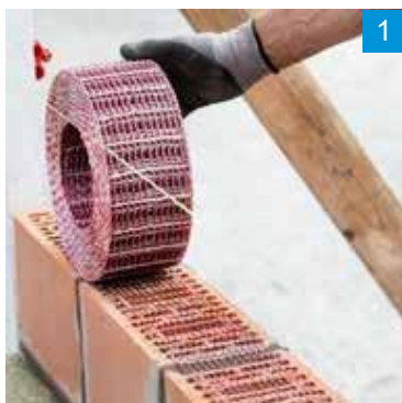
1 Aplicar Murfor® Compact I na junta dos tijolos.
