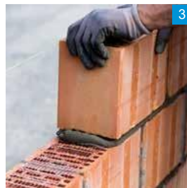
3 Colocar a fiada seguinte dos tijolos.
