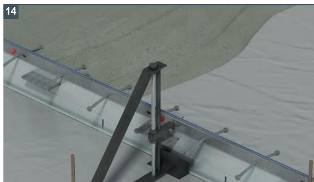
14 Verta o betão verificando a altura e a posição da junta.
