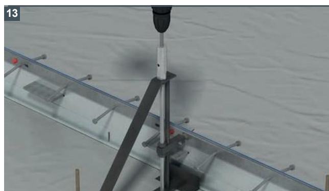
13 Inspeção visual final, ajuste a posição e a altura da junta, se necessário.
